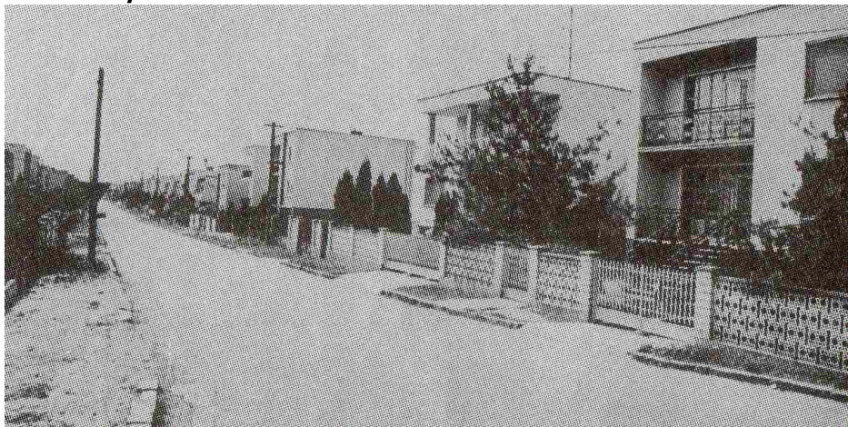
A modern Építő út
