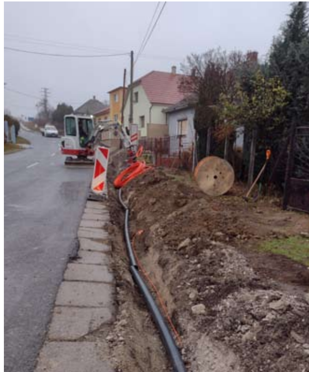
Rekonštrukcia chodníka v časti Rožňové Mitice
