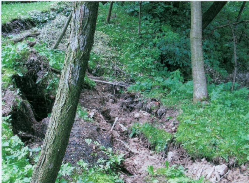
Obr.5: Zosuvom potrhaný svah pod rodinným domom č.93
