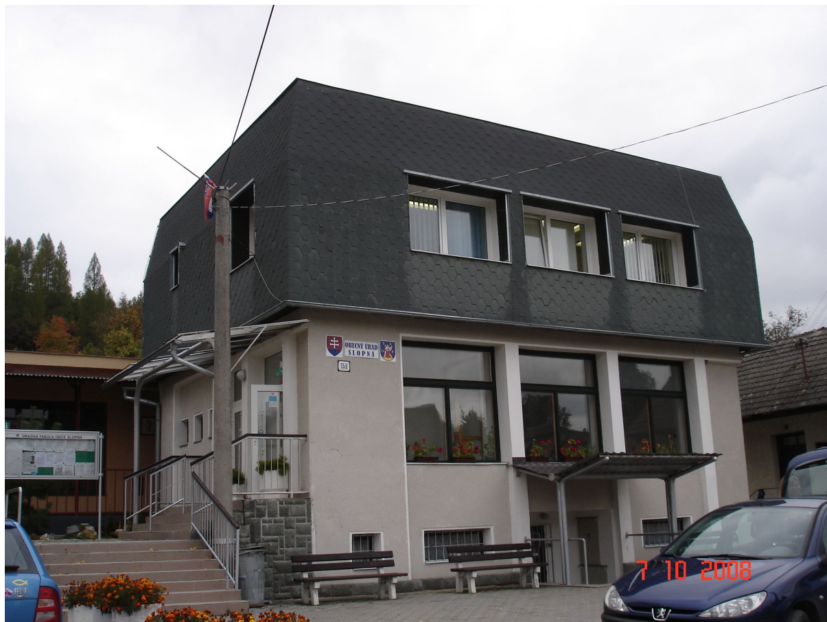
Obj. č. 25 : Foto : Budova Obecného úradu
