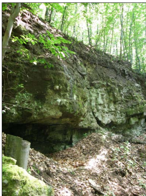
Obr. 4. Zvalený prevys na pravej strane kaňonu Pod mešterovým lazom (foto P. Urban)
