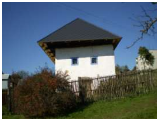
Obr.č.2 Dom ľudového bývania po oprave strechy
