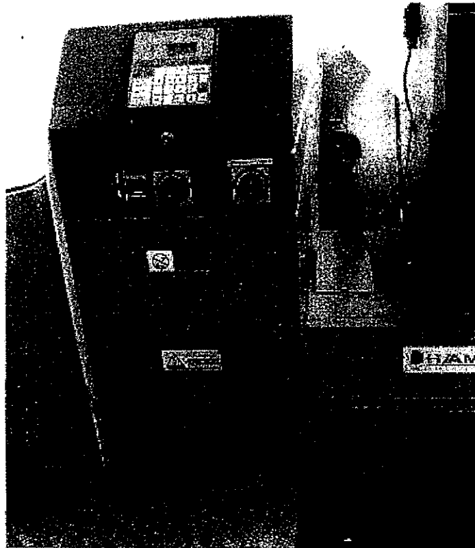
Foto č. 4.8 – Ovládanie druhého kotla CATFIRE 450 USZI - Ubľa
